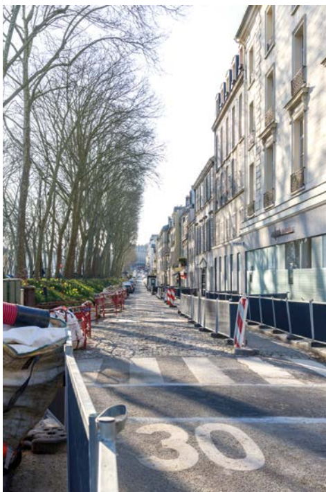
Première phase des travaux avenue de Saint-Cloud.
